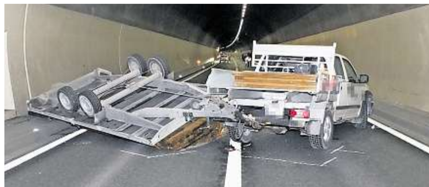
Hoher Sachschaden nach dem Unfall an den Fahrzeugen und dem Tunnel.
