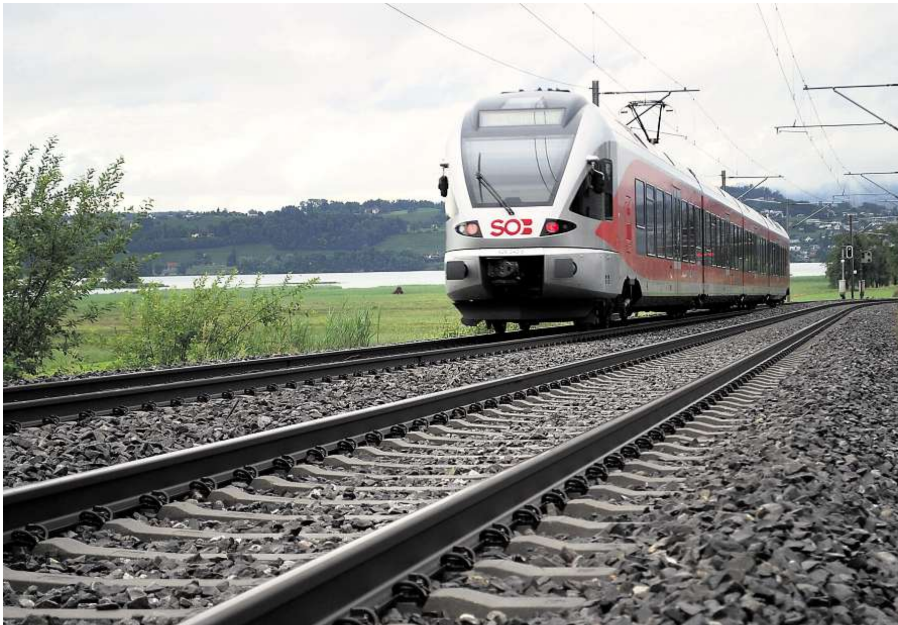
Die Betonschwellen auf der Strecke über den Seedamm wurden noch in der Schweiz hergestellt. Neu kauft die SOB sie in Polen. Bild: Marc Ulrich
