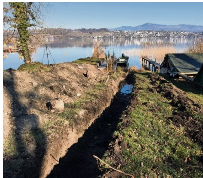
Von dieser Stelle an der Lützelau gelangen die Leitungen in den Zürichsee.
